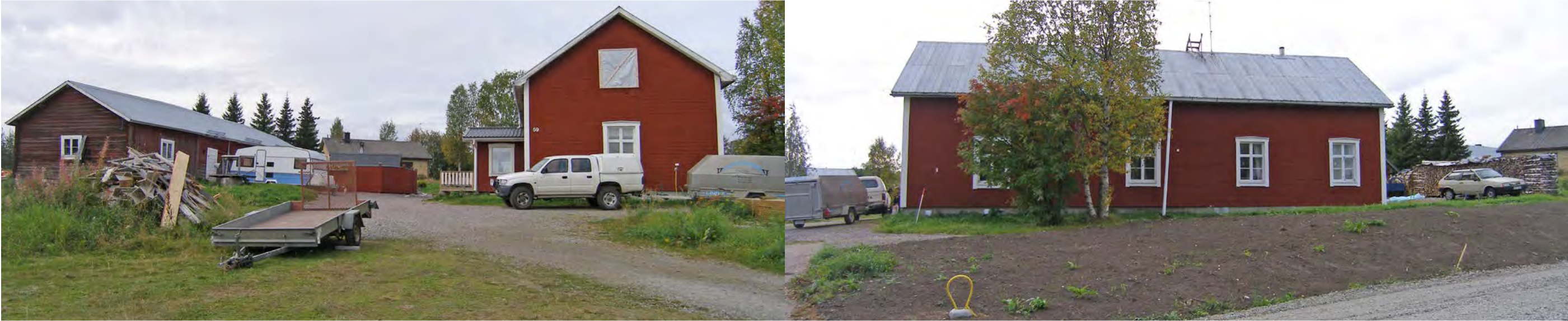
Tornedalsgården på Kirunavägen 59 med mangårdsbyggnad och uthuslänga mitt emot varandra. Tornedalsgården och gårdsbilden är välbevarad med ett högt kulturhistoriskt värde. Kirunavägen 59.
