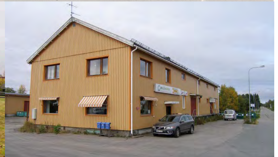
Kirunavägen 49, en långsträckt plåtinklädd byggnad inrymmer flera företag.
