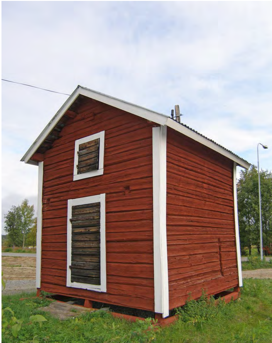
Aitta med vasformade väggar - ett byggnadsskick som är unikt för Tornedalen i Sverige. Kirunavägen 59.
